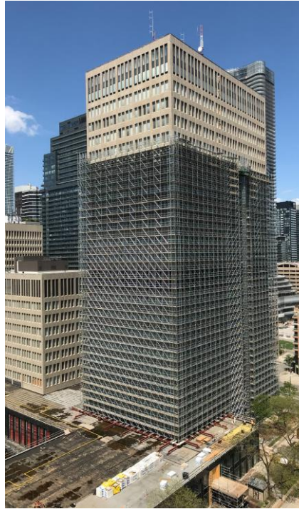
Image : Échafaudage pour la restauration de l'enveloppe de la
